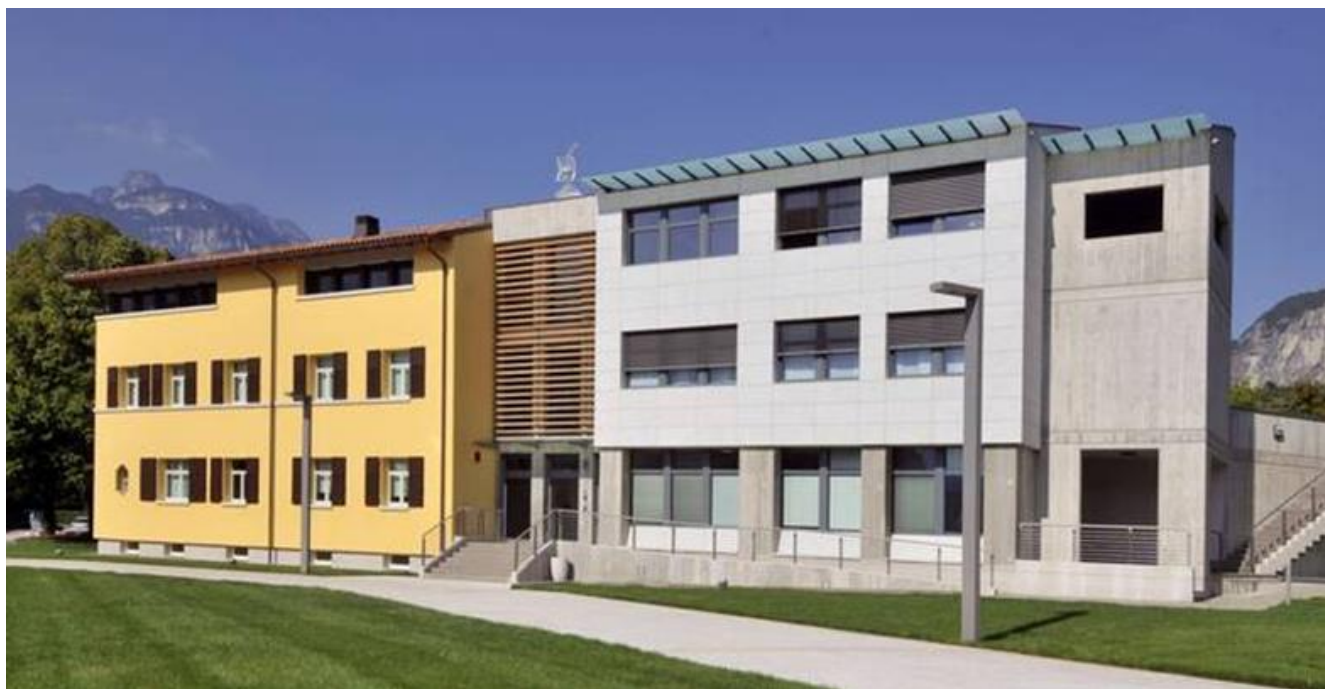
Palazzina centro Trasferimento Tecnologico, sala riunioni secondo piano (Sala Gialla)
